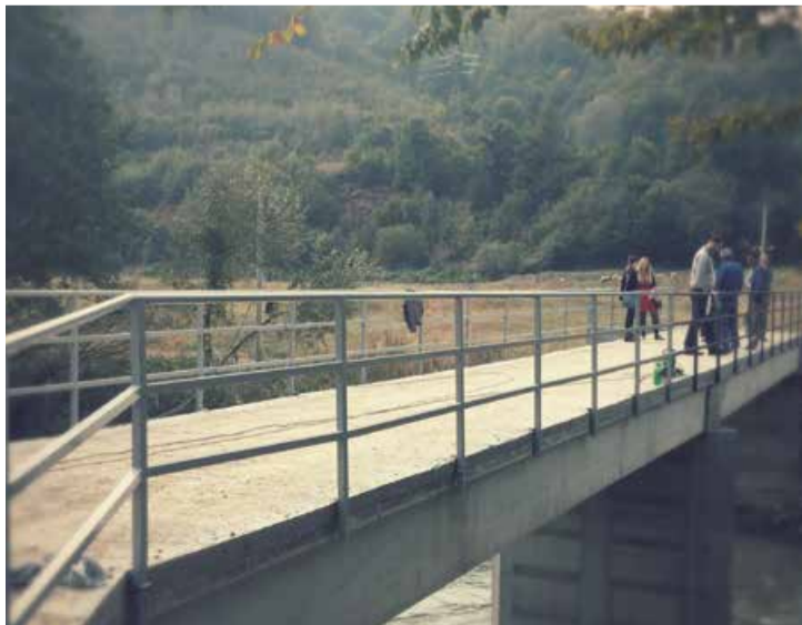
Die erneuerte Brücke
